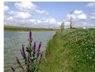
Bassin de rétention paysager ZA, St Pathus (source : CPA Conseils)
