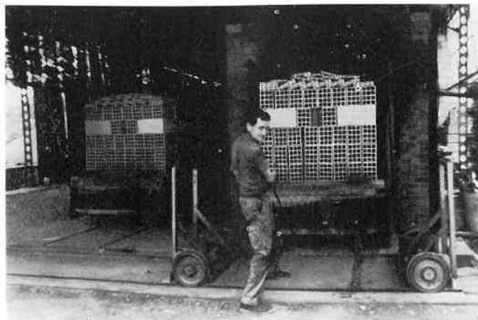
*La sortie d'un chariot du four-tunnel*
